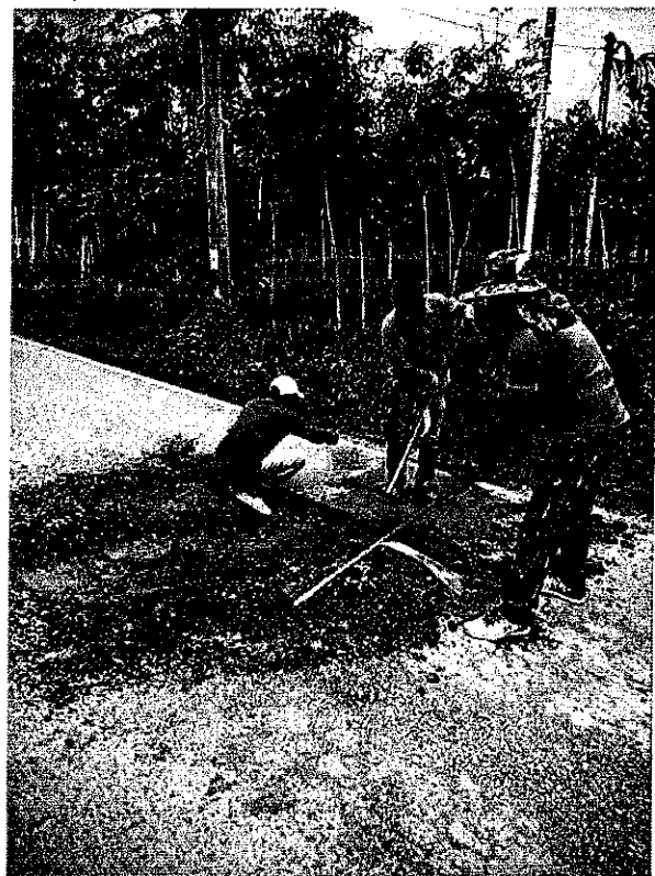
๓. ซ่อมแซมถนนชำรุด ในพื้นที่ หมู่ที่ ๘ ตำบลดุสิต อำเภอลำพูน จังหวัดนครศรีธรรมราช
